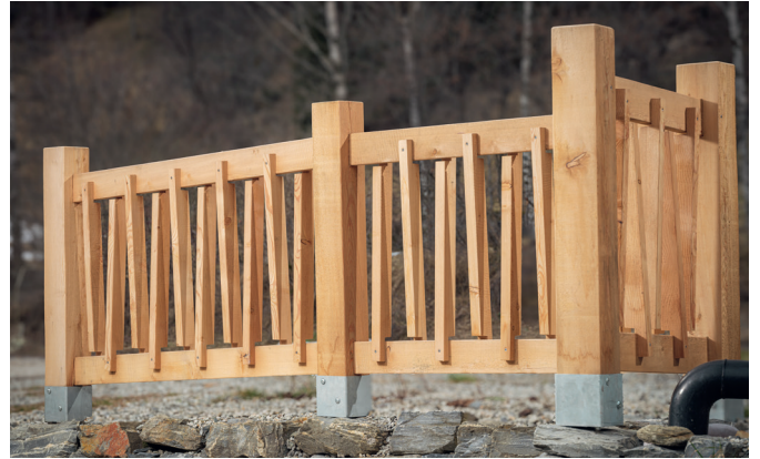
Lärchenzaun mit Staketen über Kreuz montiert
