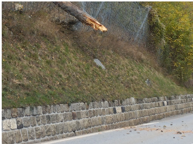
25.10.2024: Baumschlag in Schutznetz Bader, Grengiols
