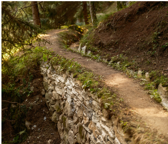
Sanierte Sohlenbicki, Tretschbord und Trockensteinmauer
