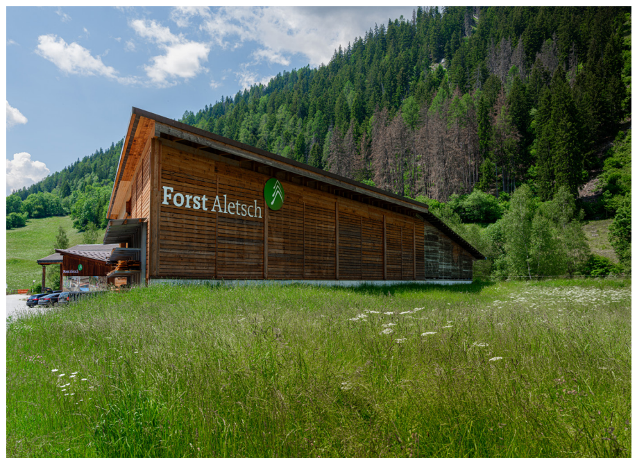
Werkhof in Fieschertal mit Büros, Werkstatt, Brennholz- und Holzschnitzellager
